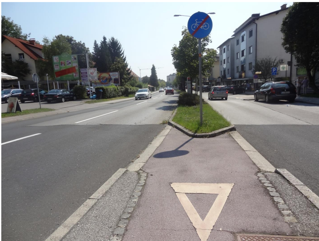
Nevarno vključevanje kolesarjev na cesto
